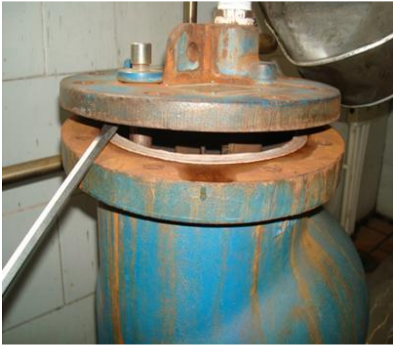
端盖、连杆、浮球和翻转机构：
